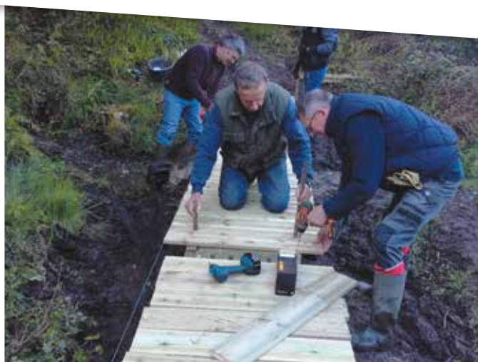
Association Saint-Thégonnec Patrimoine Vivant Montage d'une passerelle sur une partie humide avec franchissement d'un ruisseau, sur le circuit de randonnée et de VTT de Pont-Hir
