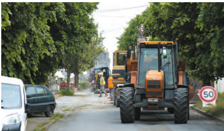
Travaux d'aménagement avenue de Kerizella
