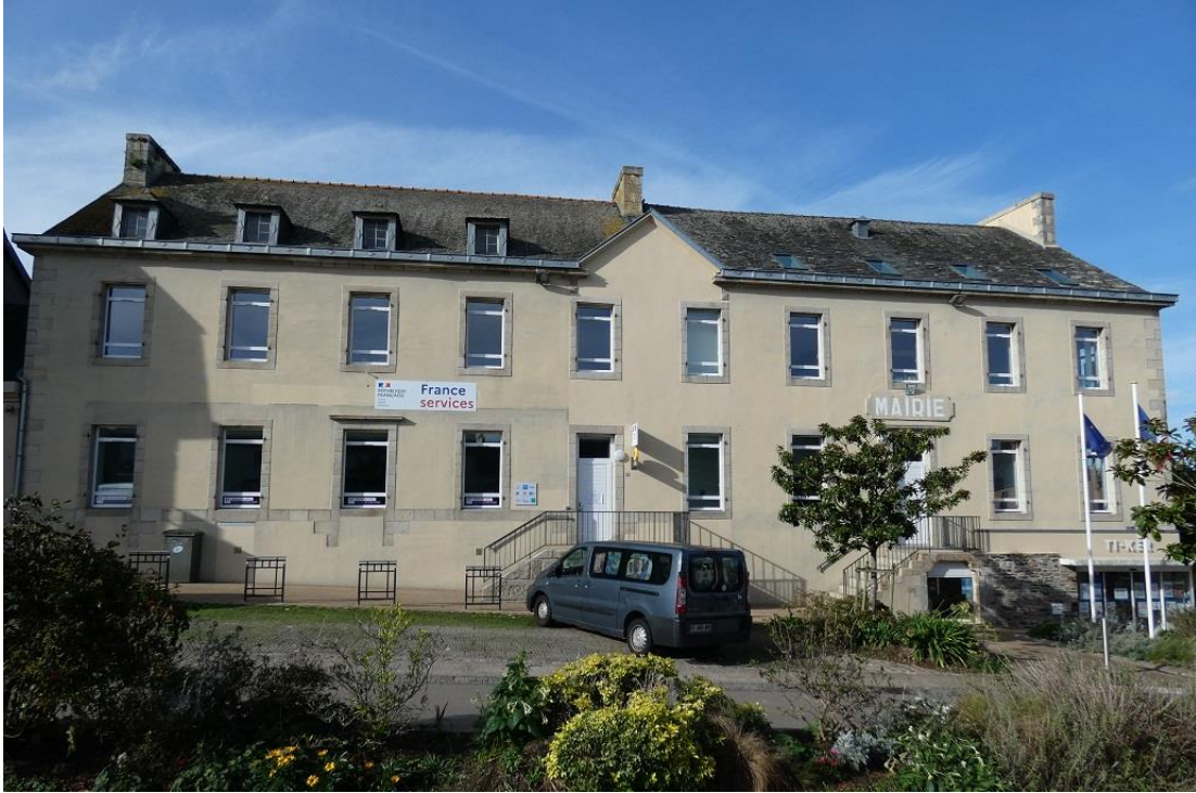
| Façade de la France Services et de la mairie de Saint-Thégonnec Loc-Eguiner
